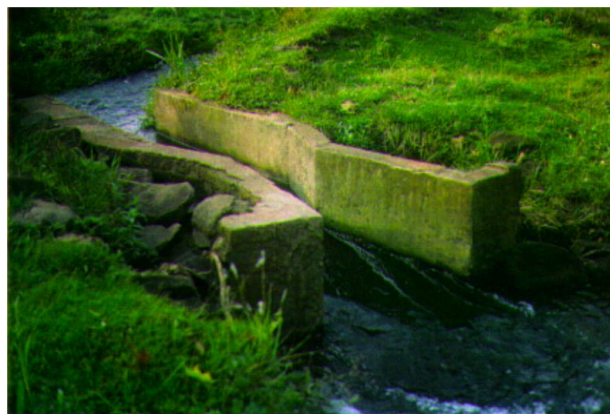
Figura 5. Calha de fundo raso de Schneider 1 em Sapiranga.
